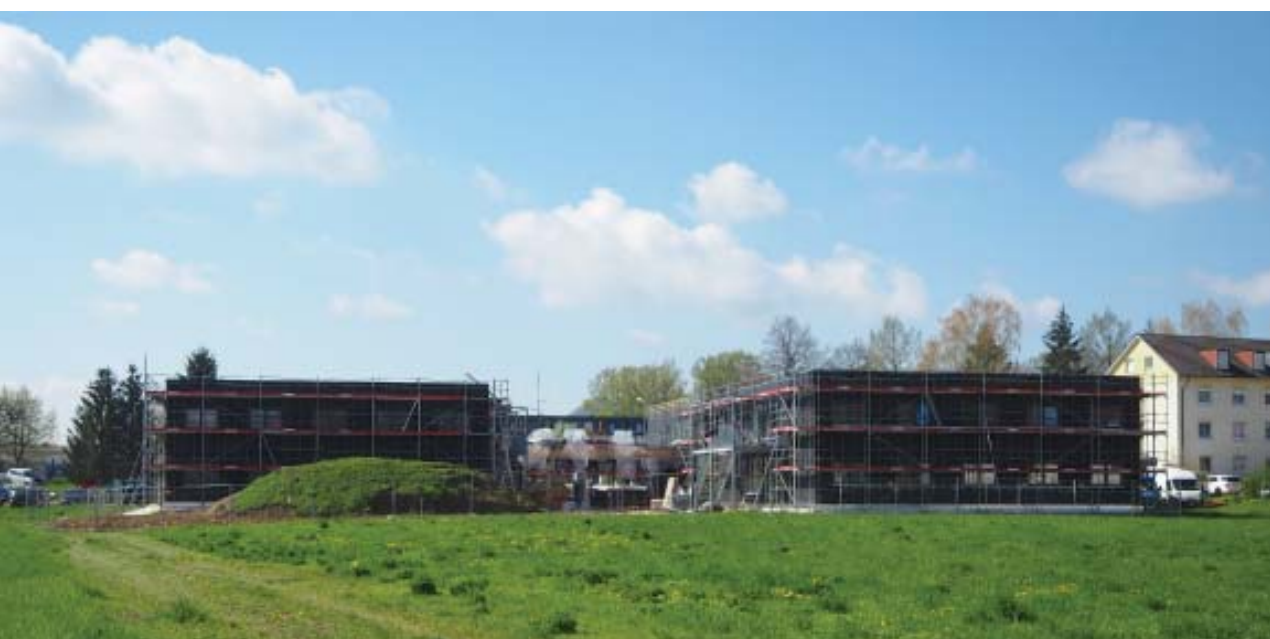
Construction site / Photo: © architektur:labor martin hoiker
